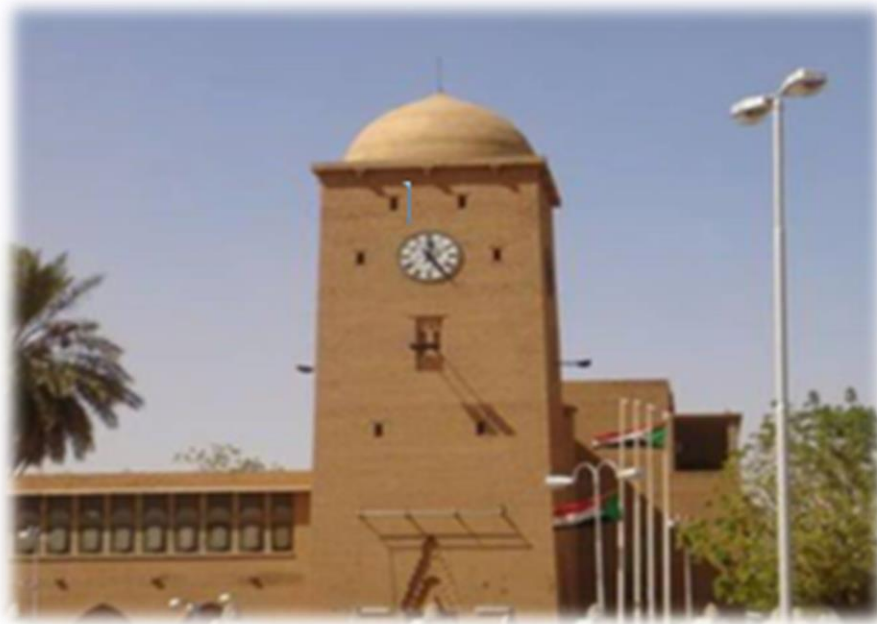
صورة (8): مبنى البلدية، أم درمان.
